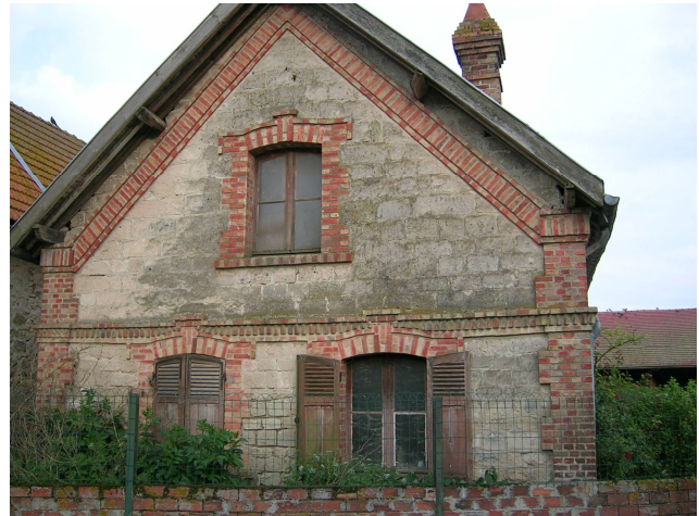
Doc 78 : maison à appareillage de briques à couleurs variées (selon la cuisson oxydante ou réductrice) et de pierres de taille 751
