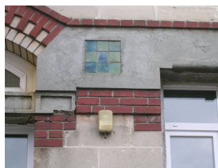
Doc 121 : détail de la façade de la mairie-école de Chevregny : assemblage de carreaux de faïence à dégradés de bleu et vert de façon géométrique (cubes) 818
