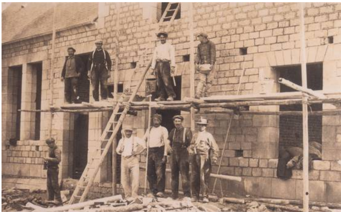
Doc 154 : équipe de maçons prenant la pose, écoles Saint-Waast. Echafaudage en boulines. Les trous pour l'étage suivant est prévu au dessus du niveau des fenêtres. L'échafaudage monte en même temps que la construction, d'où la grande échelle 891
