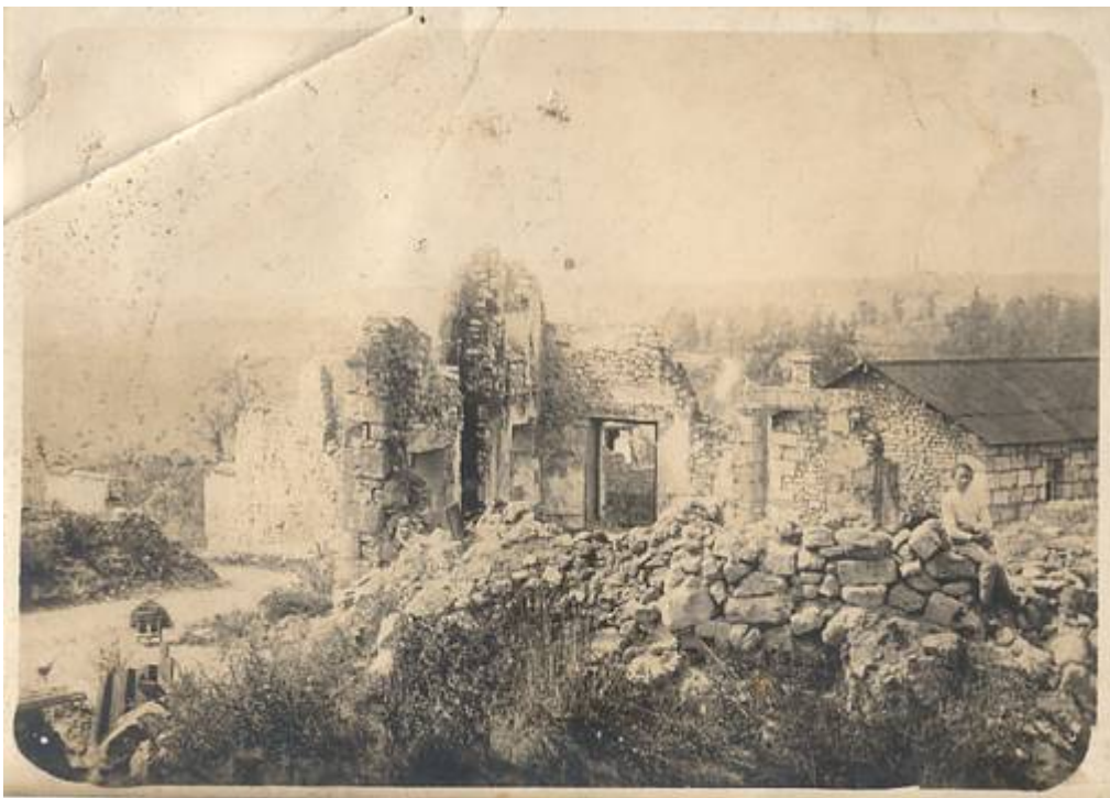
Doc 40 : semi-provisoire en moellons de récupération fraîchement jointoyés à Oulches dans les ruines ; tas de pierres au premier plan ; un gamin pose ; vers 1920 265
