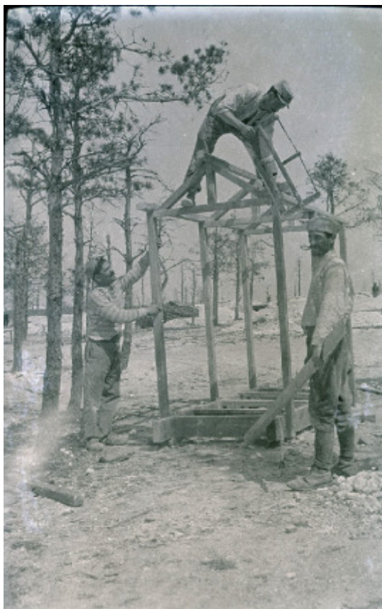
Référence : D171-1-430 Camp A. Mai 1916. Construction d'un WC.
