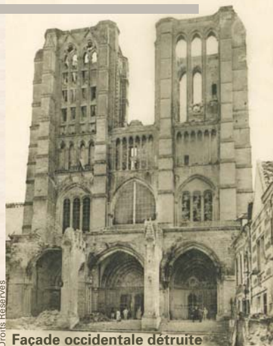
Façade occidentale détruite
