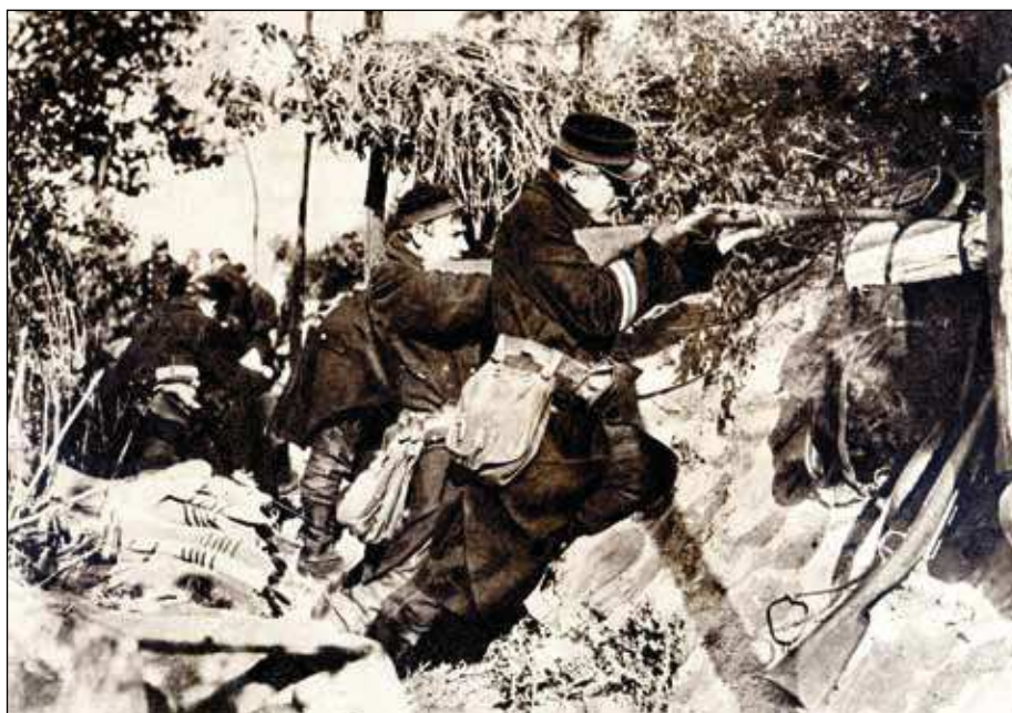
Soldats dans une tranchée devant Anvers. Le parapet est renforcé par des troncs d'arbre et camouflé par des branchages. Photo extraite de 1914 illustré , n°14, novembre 1914.
