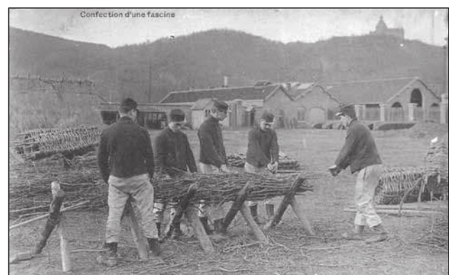
Construction de fascines au polygone du génie à Jambes en 1914, avant la guerre. Carte postale coll. Jean-Pol Maroye.
