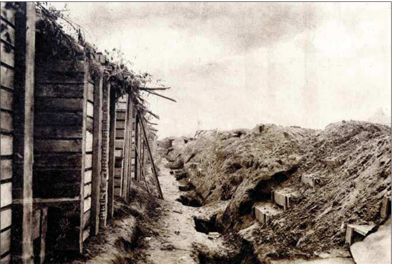
À droite, le parapet de la tranchée. Des trous espacés accueillent des tireurs debout; les escaliers permettent des sorties. Photo extraite de 1914 illustré , n° 14, novembre 1914.
