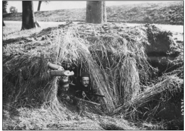
« Une construction des soldats belges pour se protéger contre l'humidité et le froid » (1914). Il s'agit en fait d'un tronçon de tranchée-abri camouflée, avant l'hiver en tout cas, peut-être dans la région d'Anvers. Cliché agence Rol. Paris, Bibliothèque nationale de France, EST EI-13 (400).
