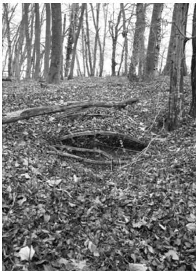
Fig. 3 - Abri de tranchée allemand en tôles métalliques cintrées dans la forêt de Carspach Lerchenberg. (Photo : M. Landolt).
