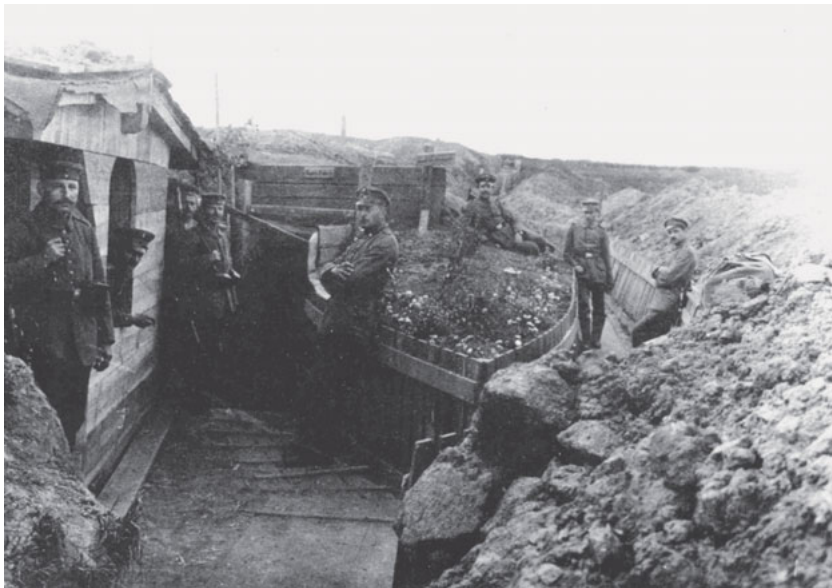
Fig. 10 - Tranchée et abri allemands en Haute-Alsace. On remarque le faible enterrement de l'abri, la technique de construction qui associe bois, des plaques métalliques (?) et de la toile goudronnée. (Photo : H. Hildenbrand, Stuttgart dans Ehret 1988, p. 125, fig. 163).
