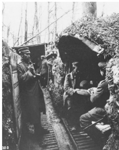
Fig. 4 - Soldats allemand jouant aux cartes dans un abri de tranchée en tôles ondulées cintrées (Gebogene Wellblechfelder) près d'Hirtzbach (Haut-Rhin). (Photo : H. Hildenbrand, col. T. Ehret, Stuttgart dans Ehret 1988, p. 134, fig. 178).
