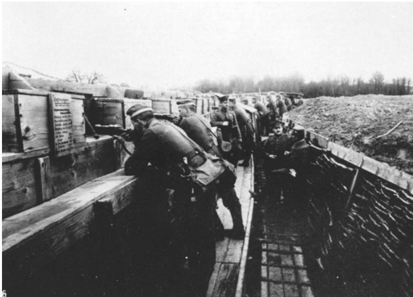
Fig. 2 - Tranchée allemande près d'Aspach avec crénaux aménagés avec des boucliers blindés. (Photo : H. Hildenbrand, col. T. Ehret, Stuttgart dans Ehret 1988, p. 125).
