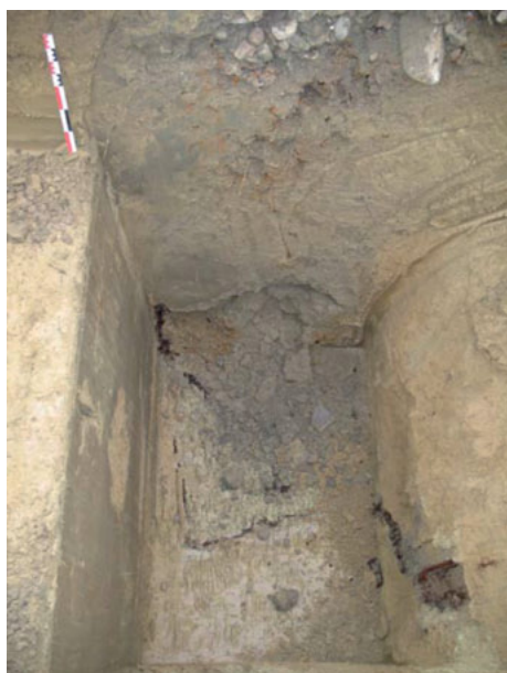
Fig. 11 – Coupe sud/nord de la galerie 21. (Photo : M. Landolt).
