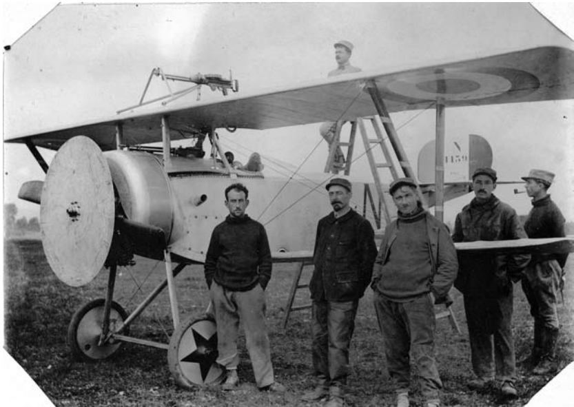
Mécaniciens armuriers réglant la synchronisation de la mitrailleuse d'un Nieuport XVI à l'aide d'un disque permettant de vérifier le passage des balles entre les pales d'hélices lorsque le moteur tourne à plein régime. Coll. ministère de la Défense, Service historique.
