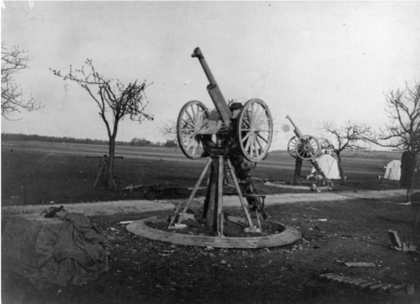
Canons de 75 mm servant à la défense contre aéronefs pour la protection du terrain de Nancy-Malzéville (Meurthe-et-Moselle). Coll. ministère de la Défense, Service historique.
