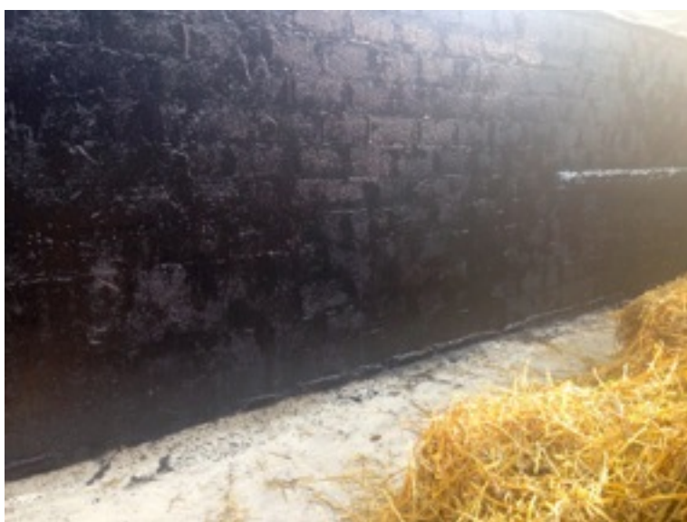
Application d'un produit étanche sur la maçonnerie
