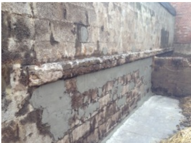
Réparation du mur de la fumière, certains joints et blocs ont été re-cimenté.
