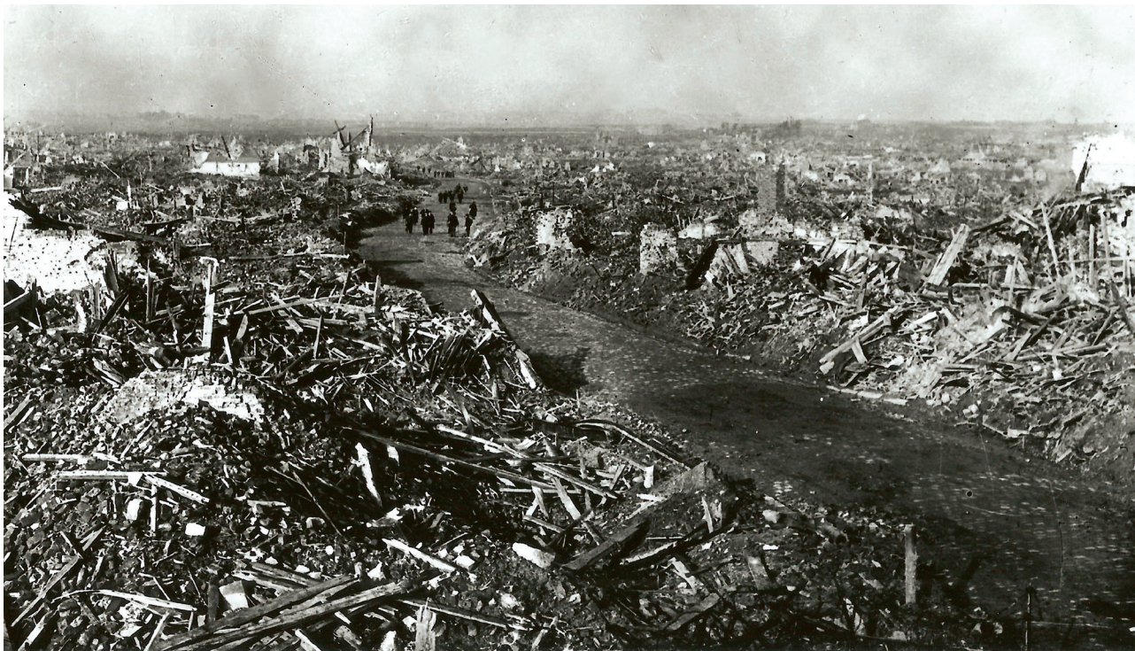
Vue générale des ruines de Lens à la fin de l'année 1918. ECPA-D, Fort d'Ivry, DR
