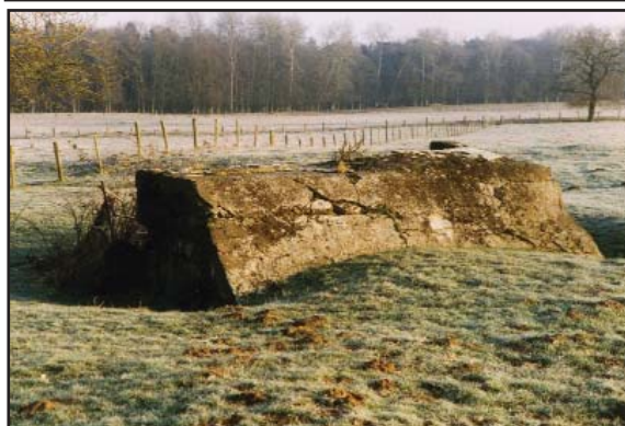
en haut Abri maçonné allemand en bordure de route à Tracy-le-Val
