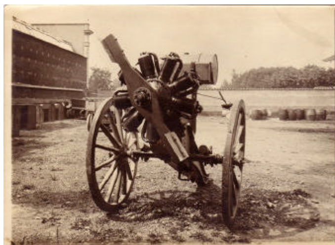
Un bien curieuse utilisation des affûts du canon de 75 mm en bancs d'essais de moteurs, ici des rotatifs Gnome et Rhône. L'avantage de cette disposition est que le banc d'essais peut être roulé sous abri après essais. (Collection CAEA).
