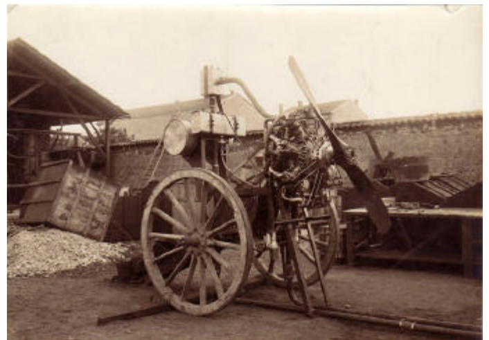
Tests des moteurs Salmson (Canton-Unné) sur banc « affûts canon de 75 mm ». (Collection CAEA).
