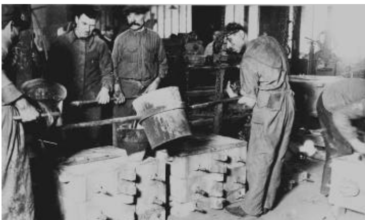
Les ouvriers coulent un piston à l'usine Gnome & Rhône de Gennevilliers en juin 1915. (Archives SNECMA).
