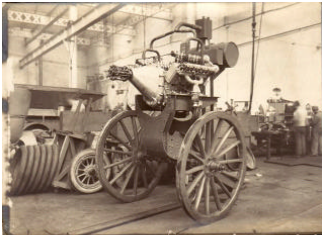
Utilisation des affûts de canons de 75 mm pour essais de moteurs d'aviation. (Collection CAEA).
