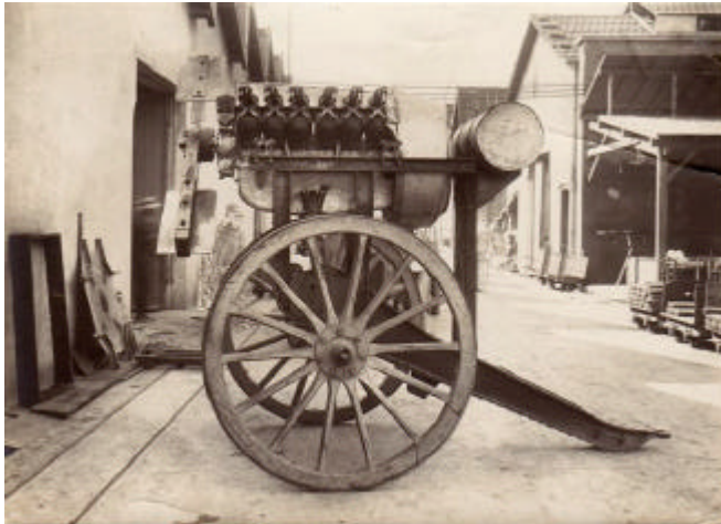
Essais des V12 A.M. sur bancs d'essais de type affûts de canons de 75 mm. (Collection CAEA).
