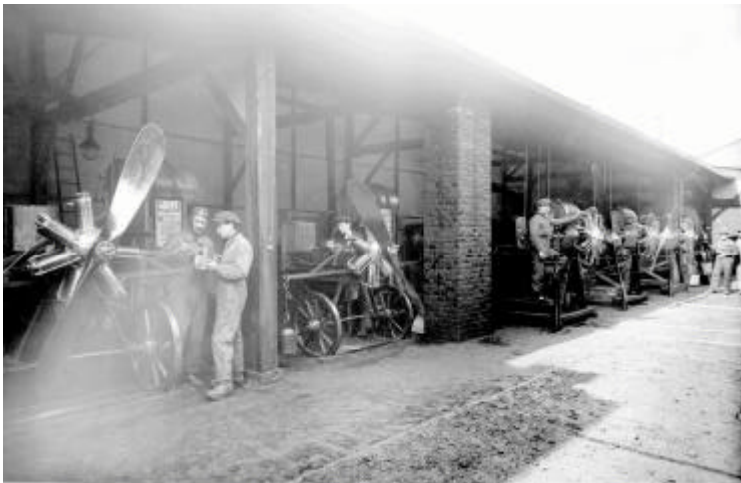
Chez Clerget-Blin, les bancs d'essais sont montés aussi sur des chariots à roues. (Collection Clerget).
